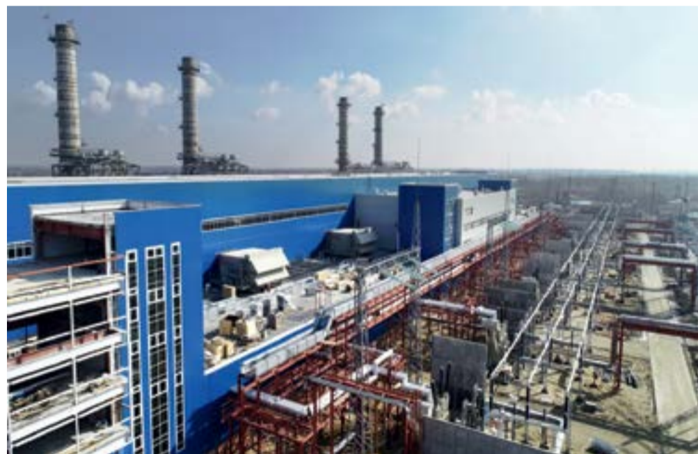
На строительной площадке Прегольской ТЭС
